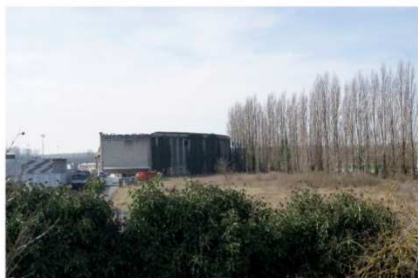
LA ROTONDE PATRIMOINE ARCHITECTURAL
